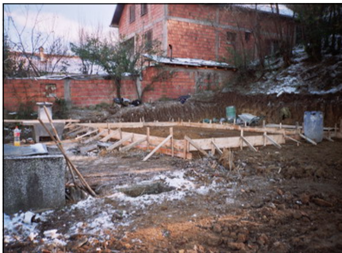
Изградња повратничке куће у селу Смаћ
