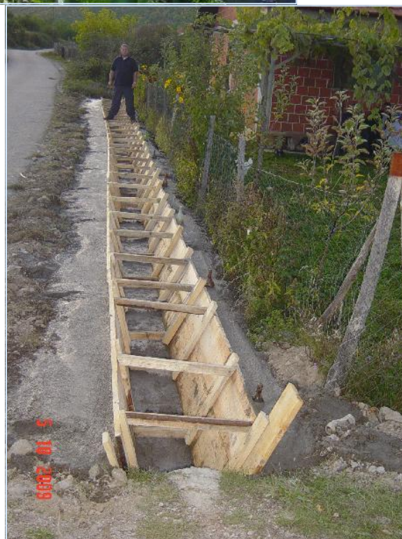
Канали за наводњавање у Брестовику - донација по пројекту
